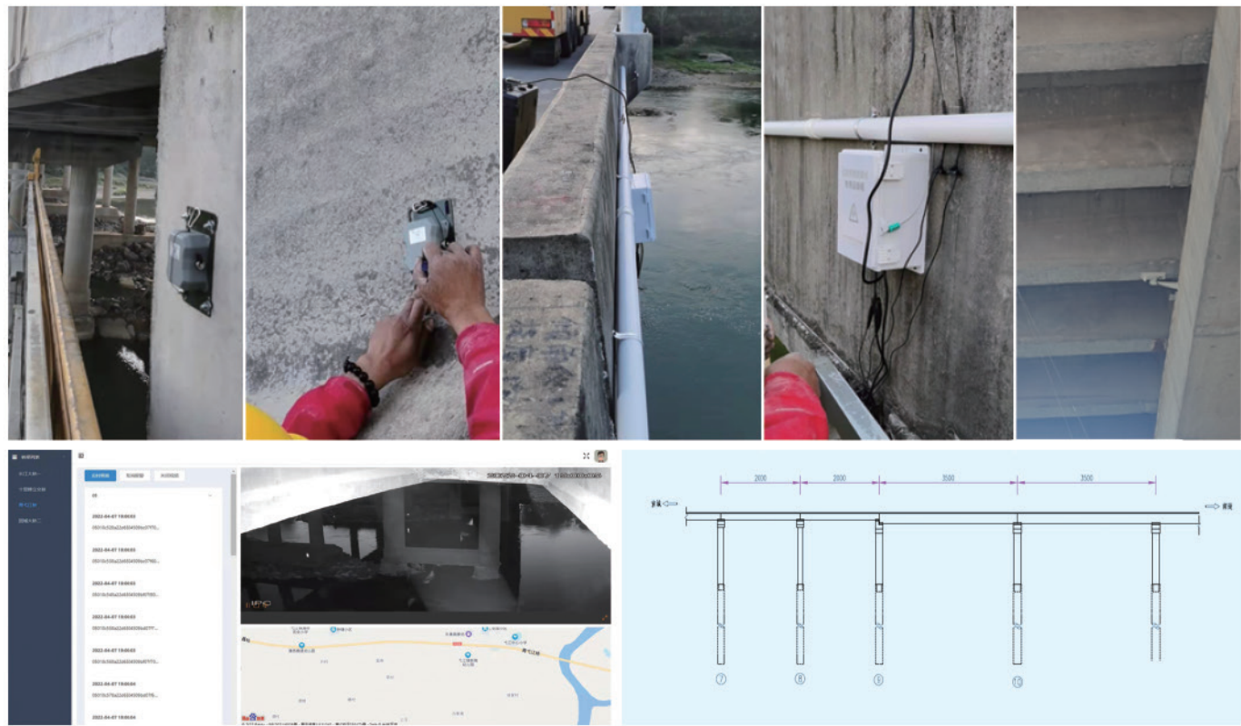
安徽芜湖青弋江大桥示范应用
